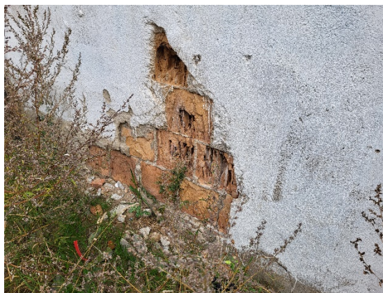
Fot. 26 Degradacja struktury ściany zewnętrznej od strony zachodniej
