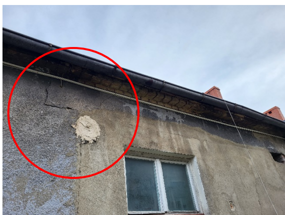
Fot. 23 Pęknięcie ściany zewnętrznej w miejscu łączenia fragmentów domurowanych.
