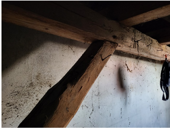
Fot. 13 Miecz i połączenie z jętką (szczyt południowy).
