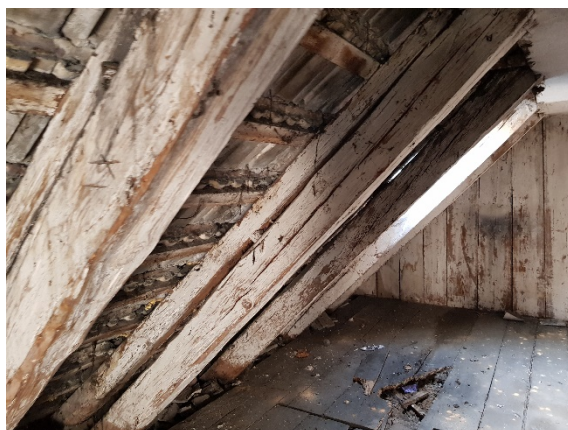
Fot. 12 Stan krokwi na połaci wschodniej dachu (ul. Koszalińska)
