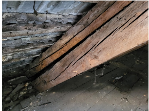
Fot. 14 Odspojona nadbitka krokwi (strona wschodnia).
