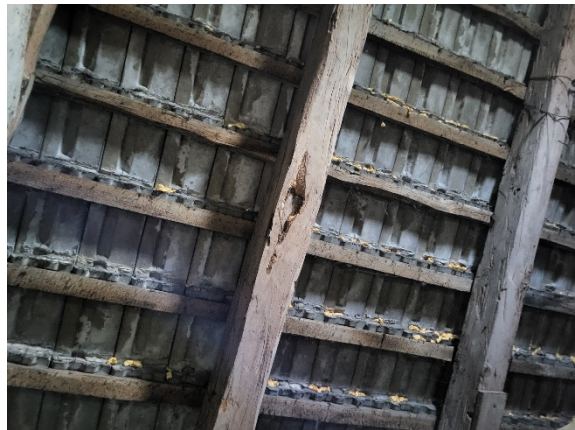
Fot. 20 Uszkodzenia elementu krokwiowego.
