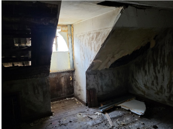
Fot. 15 Widok zniszczeń konstrukcji dachu od strony zachodniej.
