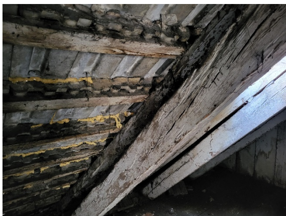
Fot. 17 Widok degradacji struktury drewna elementu konstrukcyjnego (krokiew).
