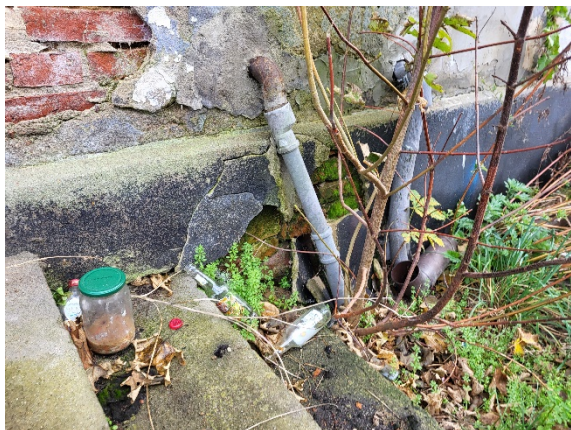
Fot. 25 Zniszczenia ściany fundamentowej spowodowane brakiem zabezpieczenia przeciwwilgociowego.
