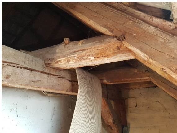
Fot. 9 Połączenie płatwi oczepowej z jętką i krokwią.
