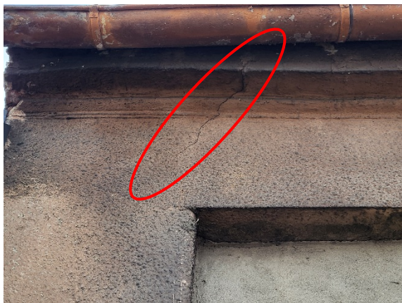
Fot. 27 Pęknięcie nadproża otworu bramy wjazdowej na elewacji wschodniej.
