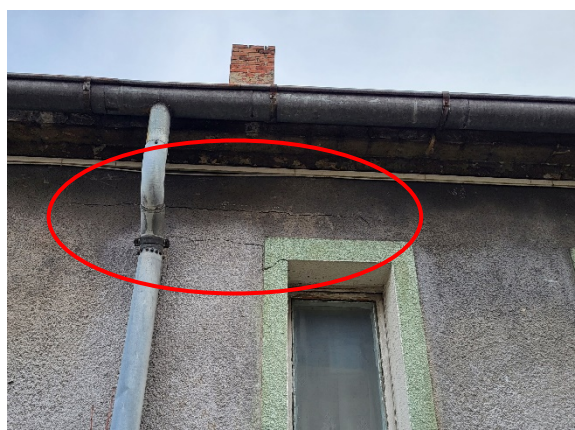
Fot. 24 Pęknięcia świadczące o rozwarstwieniu ściany zewnętrznej. Przyczyną może być brak wieńca obwodowego..
