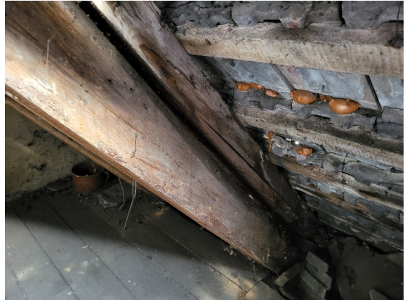
Fot. 16 Nadbitka odspojona od elementu krokwi.
