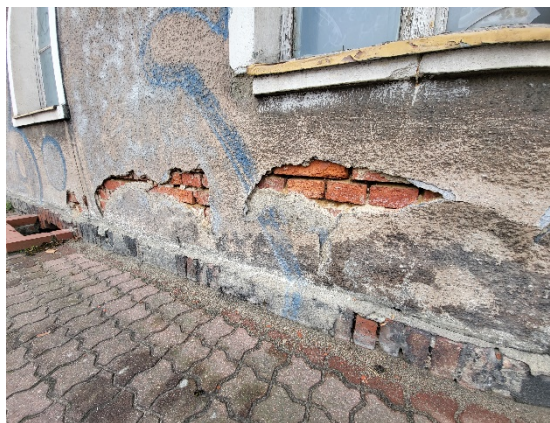
Fot. 28 Zniszczenia tynku elewacyjnego po stronie wschodniej spowodowane brakiem izolacji poziomej.
