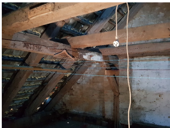
Fot. 3 Konstrukcja dachu. Widok na ścianę szczytową (narożnik południowo-wschodni).
