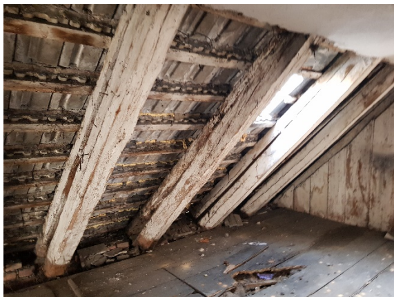
Fot. 7 Krokwie konstrukcji dachu od strony wschodniej.
